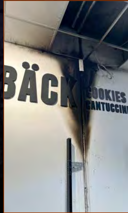
Am Tag danach. Giftige und hochkorrosive Brandgase waren in den Verkaufsraum eingedrungen und machten eine lang- wierige Brandsanierung erforderlich.
