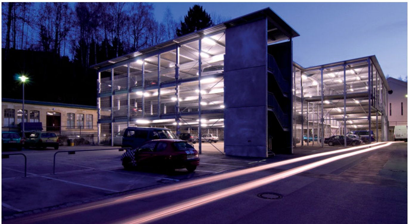
Neubau eines Parkhauses am Standort Kempten.
