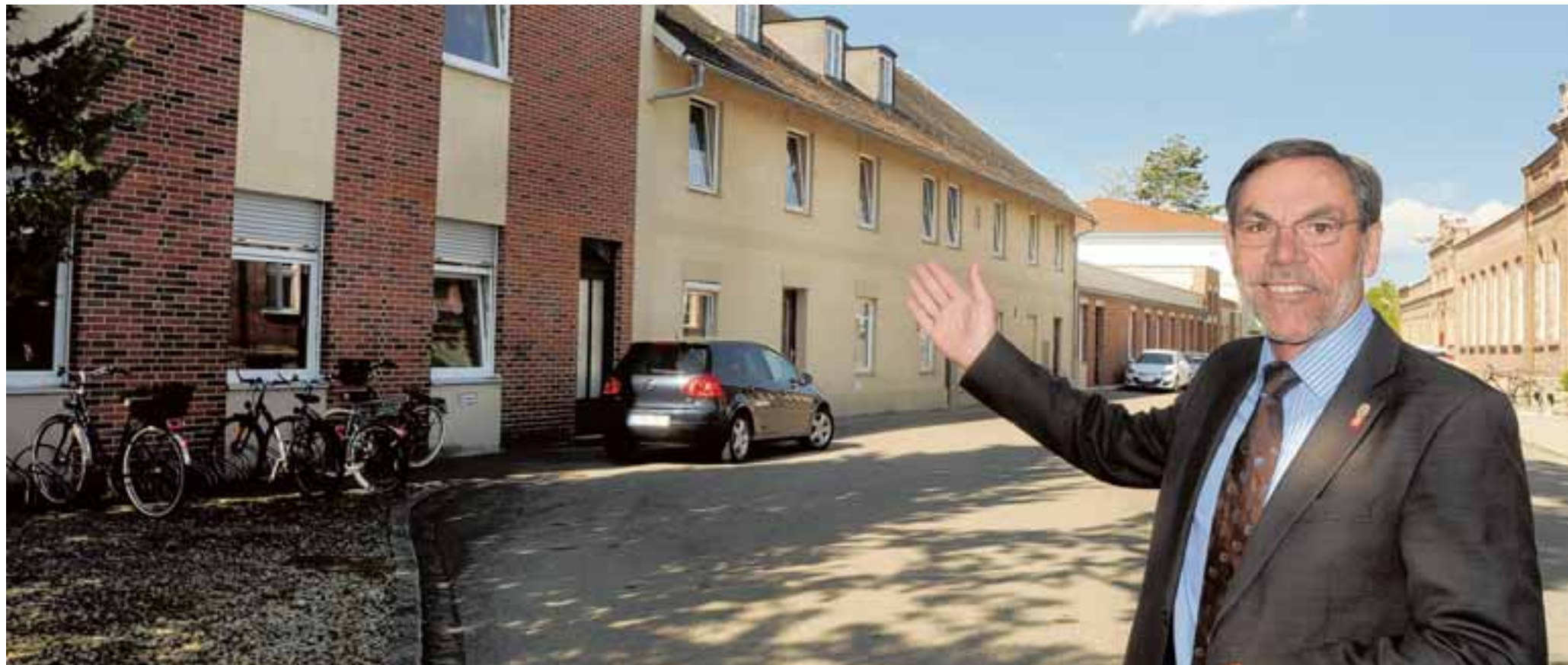
Hier ist derzeit noch das Kinderhaus Konkret untergebracht. Wenn die Kindertagesstätte ihren Neubau auf dem Sheridan-Areal bezieht, will die Dierig-Holding das Gebäude komplett umbauen und aufstecken. Vorstand Bernhard Schad (im Bild) freut sich, dass die Arbeiterwohlfahrt hier wieder mit im Boot ist. Fotos: Ruth Plössel
